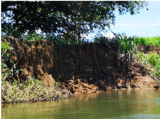
**Figura 8.** Erosión en la margen izquierda del nuevo cauce del río Parismina
