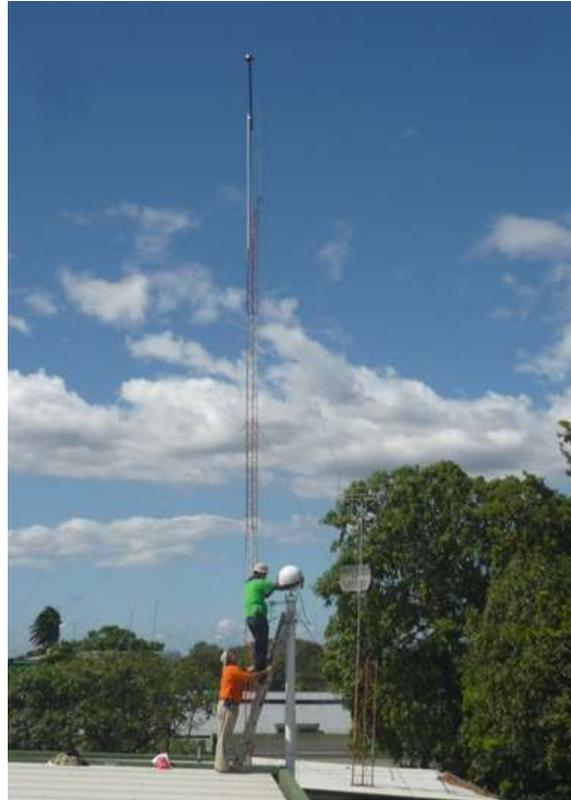
Figura 4. Mantenimiento de las antenas GNSS.[Fotografía de José Valverde Calderón].(Liberia, 2011). Archivos fotográficos de mantenimiento.
